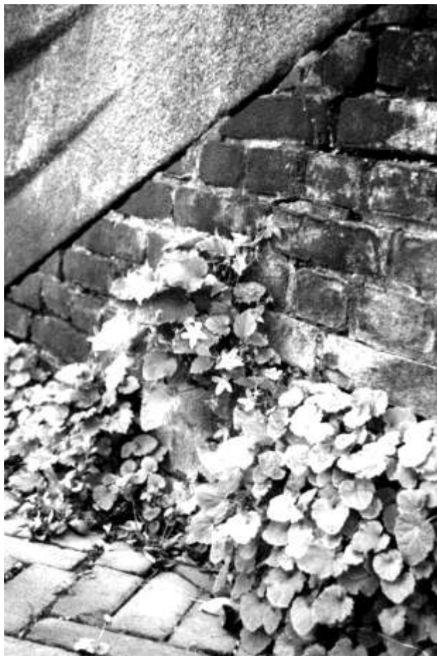
Foto 2. Dof muurklokje op de Herewegviaduct
