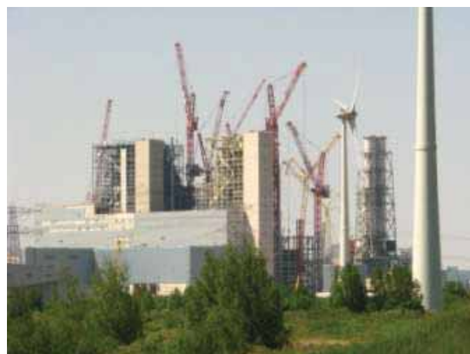
Eemshaven, bouw energiecentrale
